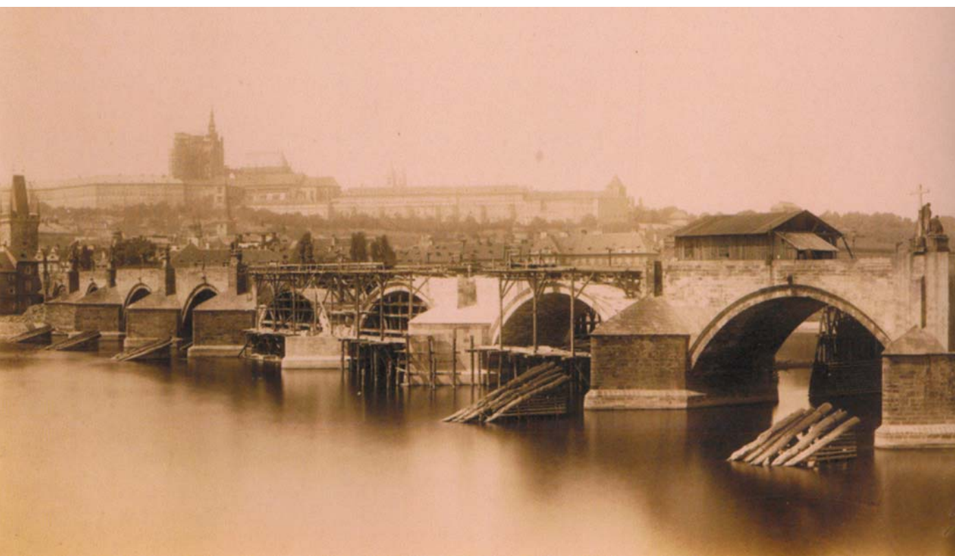
Karlův most v době oprav po povodni v roce 1890. Veřejnosti byl znovu otevřen 19. listopadu 1892. Fotografie, Muzeum Hlavního města Prahy
