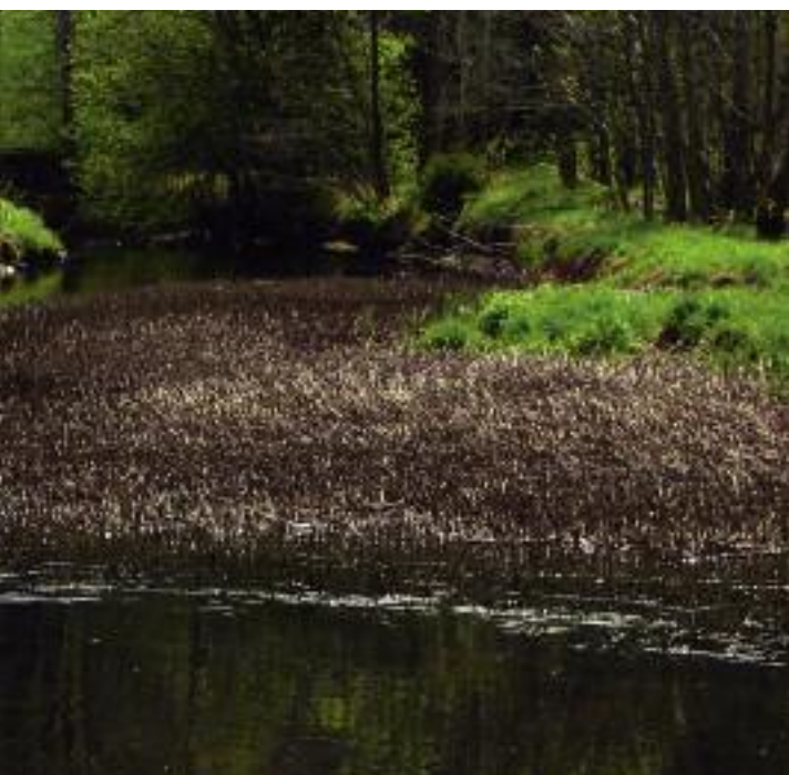
Jez na Labi (EVL Krkonoše – předmětem ochrany je mj. vranka obecná) s tzv. dnovým odběrem vody pro malou vodní elektrárnu. Tento způsob odběru ohrožuje migrace (zejména drobnějších) ryb po- i proti proudu, neboť dochází k jejich nasávání přes česle uložené ve dně přímo do přívodního potrubí na turbínu.
